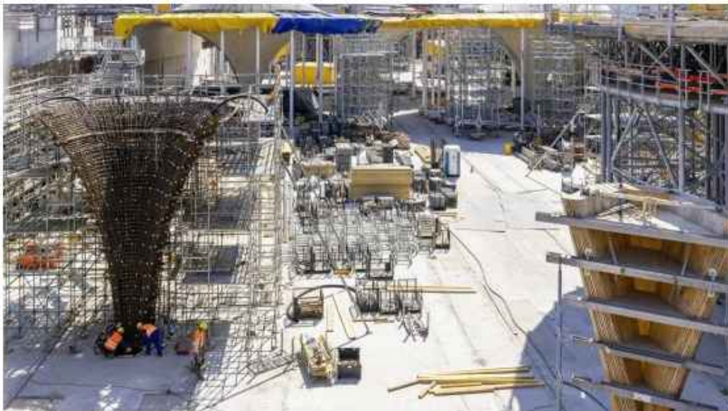
Hauptbahnhof Stuttgart, die Baustelle für Stuttgart 21 (imago / Arnulf Hettrich)
